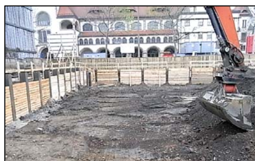
Abb. 4. Schichtenweiser Abtrag, verpflichtend bei baubegleitender KMR
