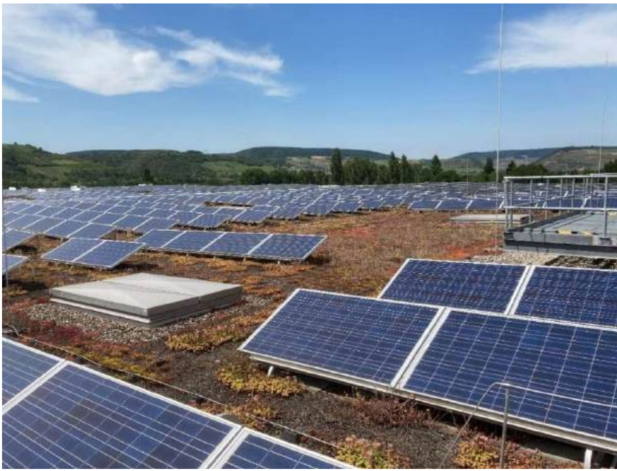
Foto 1: Beispielhafte Darstellung einer extensiven Dachbegrünung in Kombination mit PV-Anlagen auf dem Dach des Aldi-Süd Zentrallagers in Bingen am Rhein (Fotoaufnahme: ÖKOPLANA)
