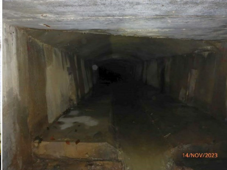
Bild 5: Weitere unterläufige Querfugen im Verlauf der Verdolung
