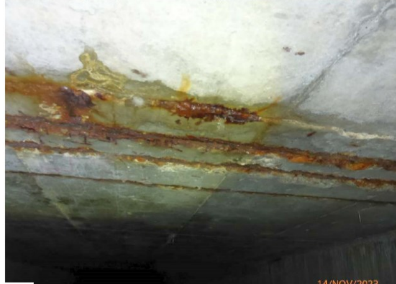
Bild 5: Weitere unterläufige Querfugen im Verlauf der Verdolung
