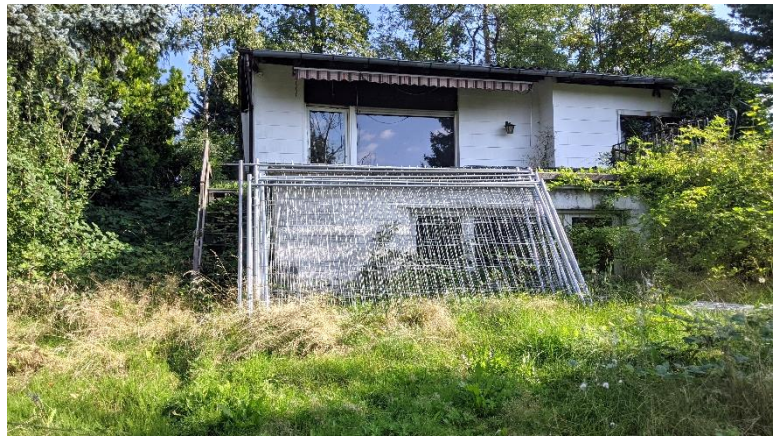
Abbildung 7: Bestandsgebäude „In der Bärenhecke 18“
