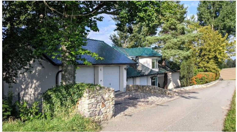
Abbildung 6: Bestandsgebäude „In der Bärenhecke 28“
