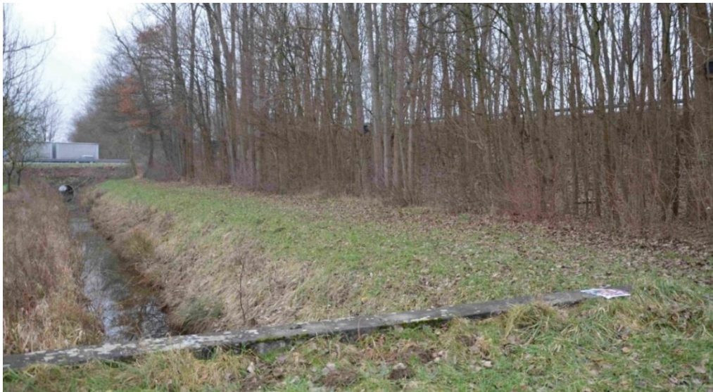
Abbildung 6: Blick auf den Bruchgraben im Bereich der Aufweitung A2 (Nordseite)
